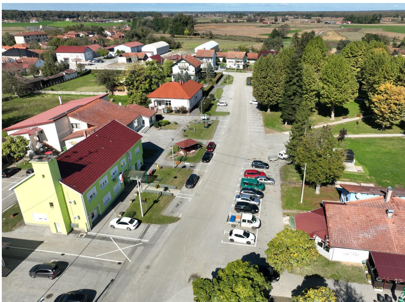
Sl. 43. Prošireni asfaltirani koridor u zapadnom dijelu Trga Slobode u Ferdinandovcu
