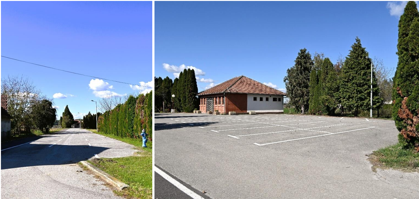
Sl. 45. Asfaltirani prilaz groblju (lijevo) s parkiralištem (desno) u Ferdinandovcu
